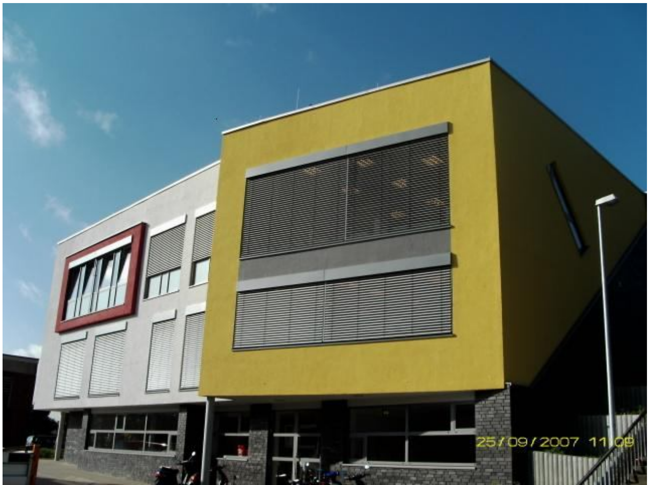
Neuer Trakt der Realschule Hilter in Borgloh
